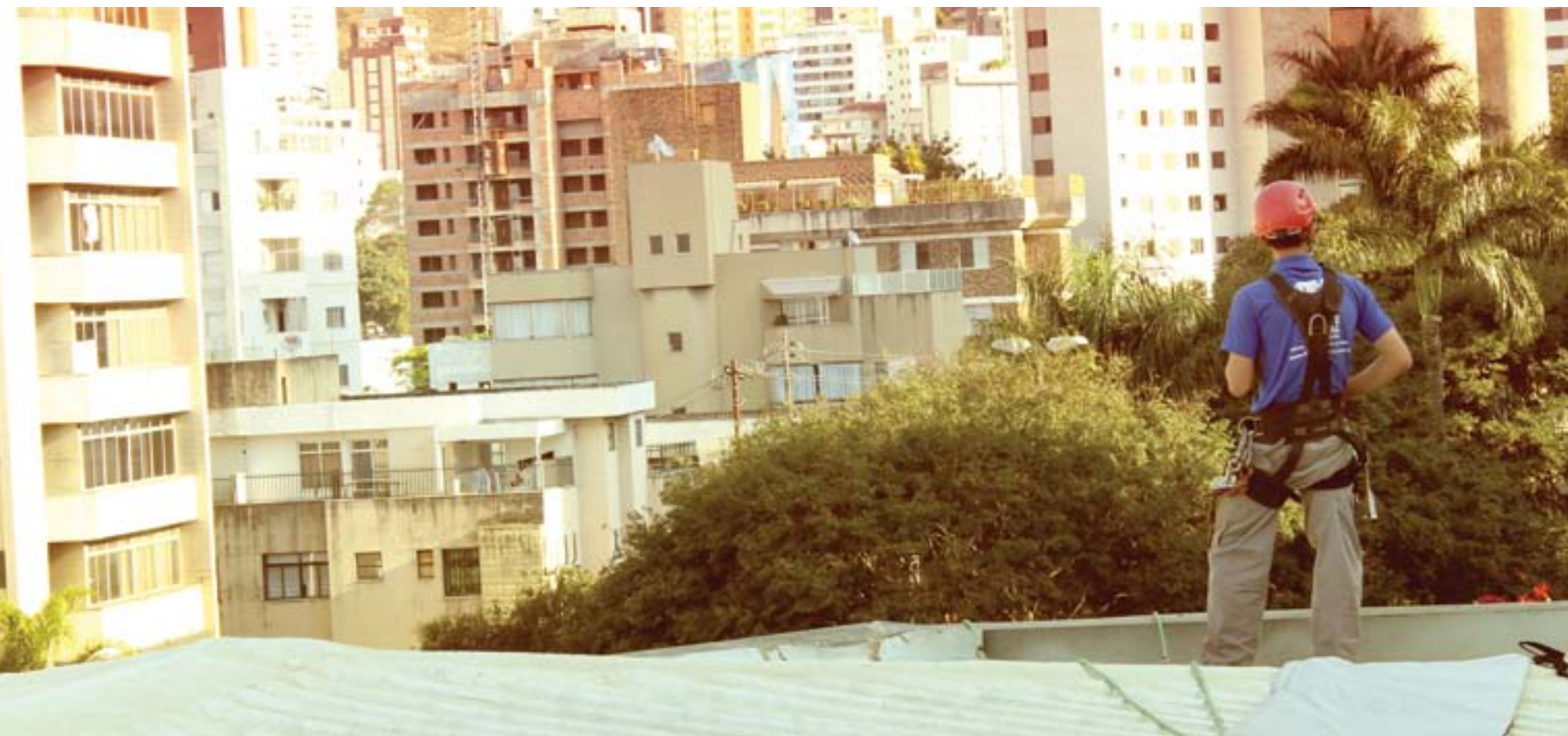
A equipe sobe até o telhado da loja para ancorar o equipamento do rapel
